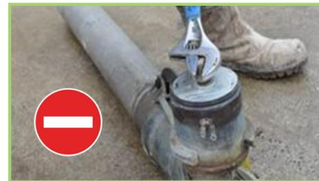
**Ne jamais resserrer la vis en laiton sur un réseau sous pression.** Utilisez un outil adapté pour le faire.
